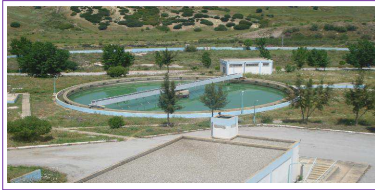
Figure 10 : Décanteur raclé à ciel ouvert
