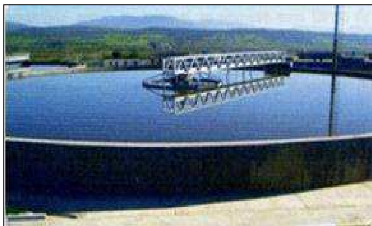
Figure 06 : Décanteur primaire (ONA, 2012).
