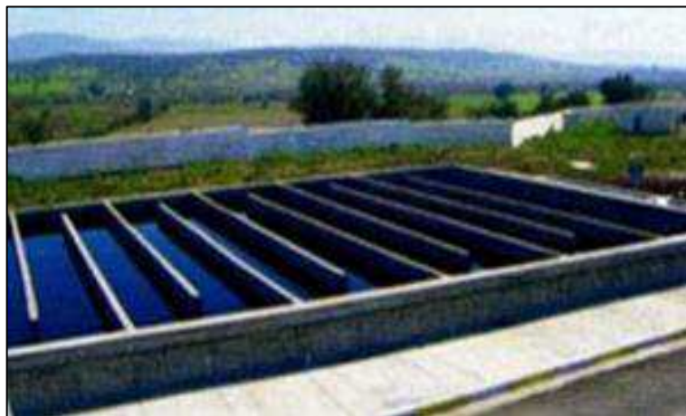
Figure 09: Bassin de désinfection (ONA, 2012).
